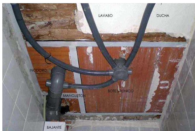
Fig. 49 Desagüe con bote sifónico.
